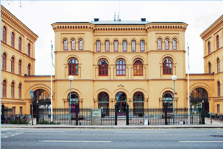
Svea Artilleriregemente flyttade 1877 in i kaserner vid Valhallavägen. Byggnaderna används i dag som kontor. Foto: Lennart Johansson
